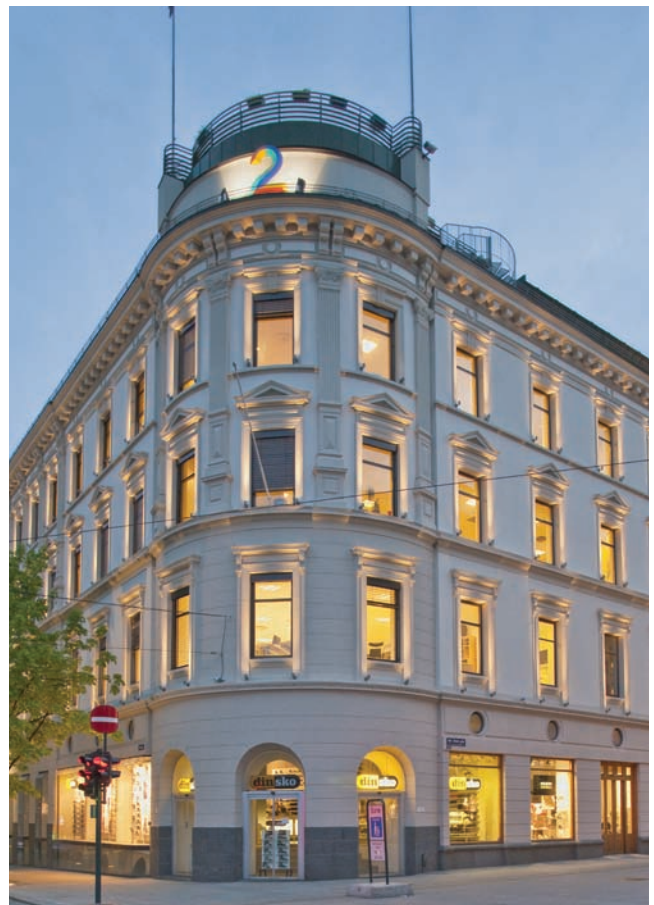
Karl Johansgate 14, Oslo. Foto: Halvor Gudim.
