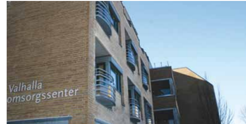
Vallhalla omsorgssenter. Energistyring har gitt betydelig energisparing. Foto: Bjørne Jortveit.
