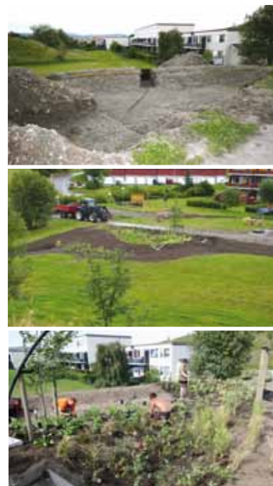
Opparbeidelse av regnbed på Risvollan i Trondheim.
