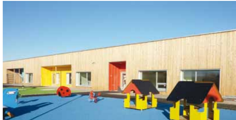
Storøya barnehage er bygget etter passivhusprinsipper. Integriert del av Storøy Grendesenter, Fornebu, Bærum kommune Arkitektkontoret Kvadrat AS.
