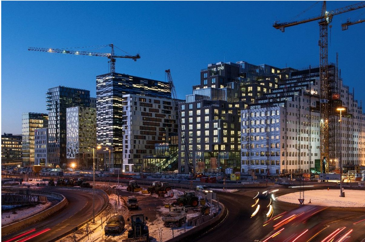
Figur 4-1: Foto som viser Barcoderekken og MAD-bygget som det slanke bygget i midten, nr 6 fra venstre, uoffisielt oppkalt etter arkitektfirmaet MAD .
