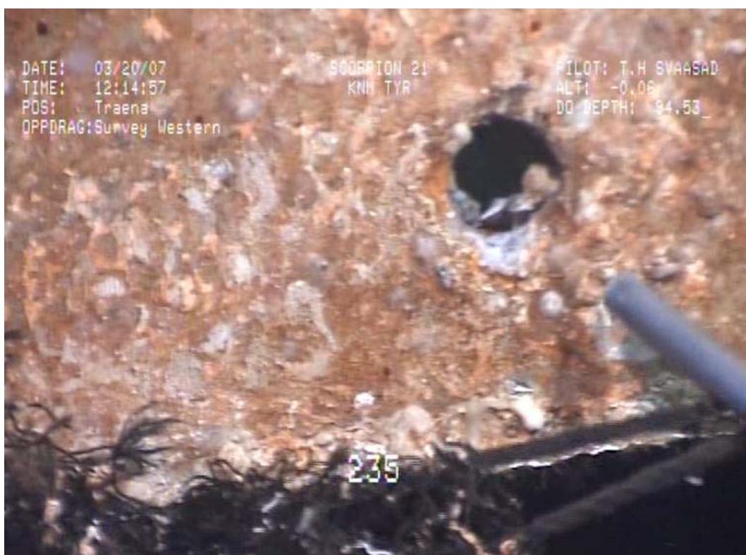
Figur 2. Hull i babord bakkdekk etter skraping med rør.
