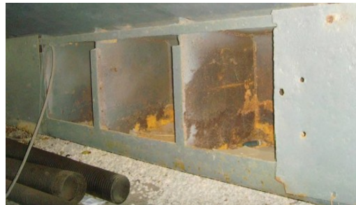
Kjølen med dekkplater demontert
