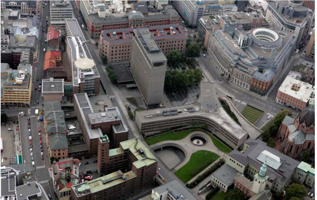
Regjeringskvartalet med Høyblokka fra 1958 og Y-blokka fra 1969, begge tegnet av arkitekt Erling Viksjø.
