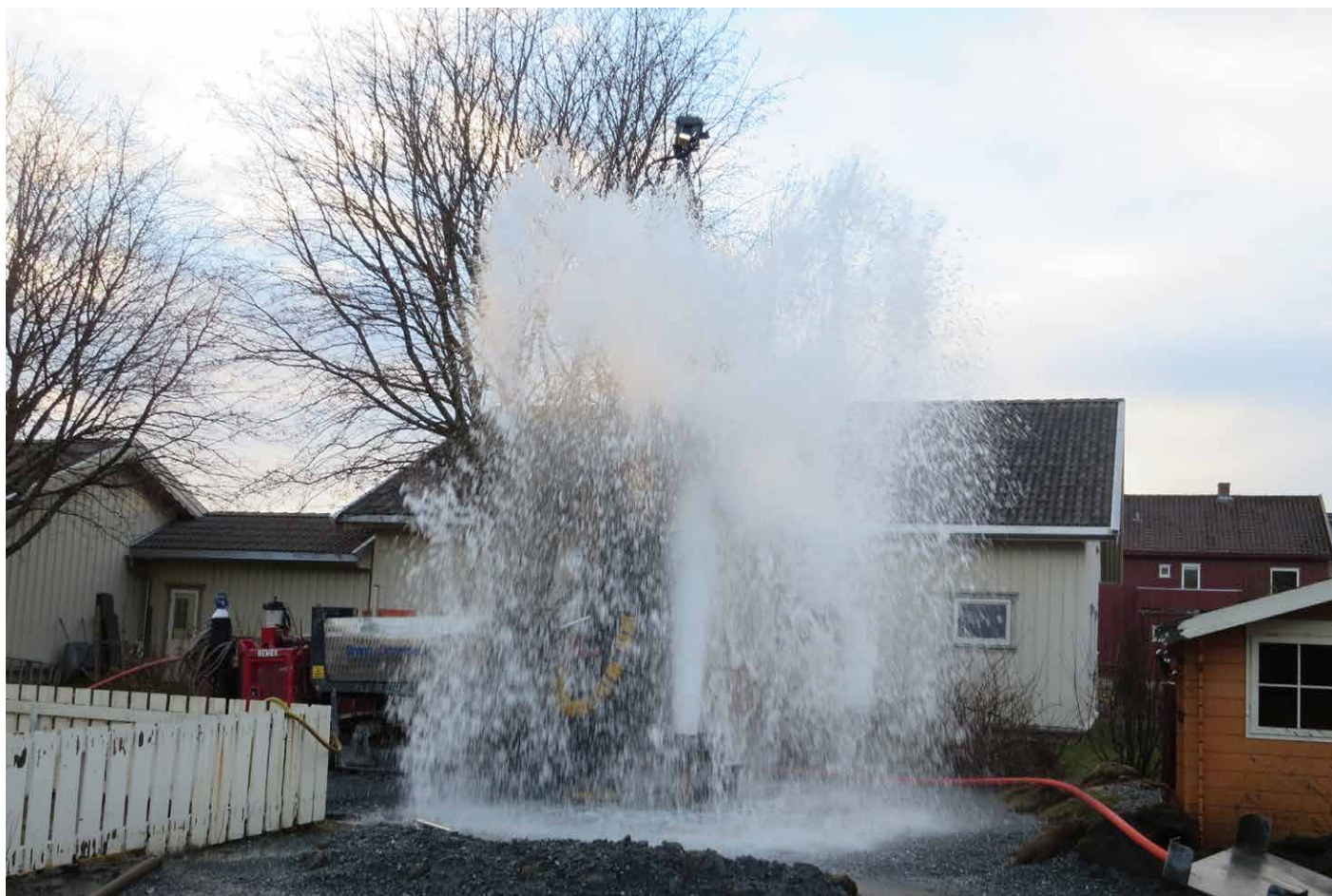
Figur 1. Vannspruten fra vaskingen av silen/filteret for en av brønnene i Melhus. Her rensyles grusen rundt silen/filteret som er plassert på 73-78 meters dybde Foto: Randi Kalskin Ramstad.
