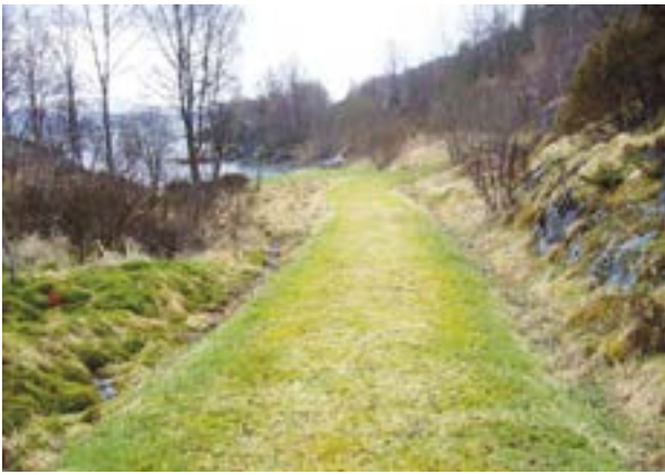
Ekstremvær fordrer solid og robust tilrettelegging. Denne ferdselsvegen har gode grøfter som kan ta unna flom- og regnvann. Foto: Bergen og omland Friluftsråd.
