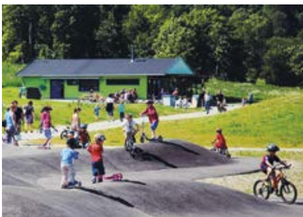
I Midsandtangen friluftslivsområde i Malvik kommune (Sør-Trøndelag) er et tidligere forsvarsbygg ombygd til servicebygg med kafe, toaletter og stellerom. Foto: Helene Kristiansen.
