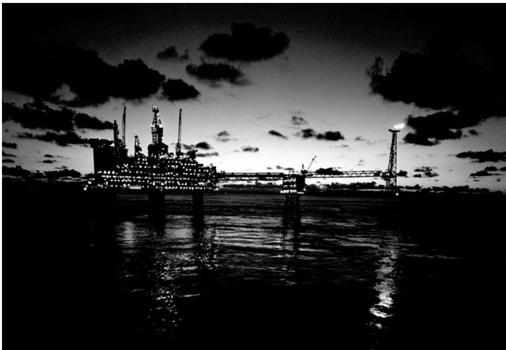
Figur 3.1 Sleipner-plattformen i Nordsjøen.
