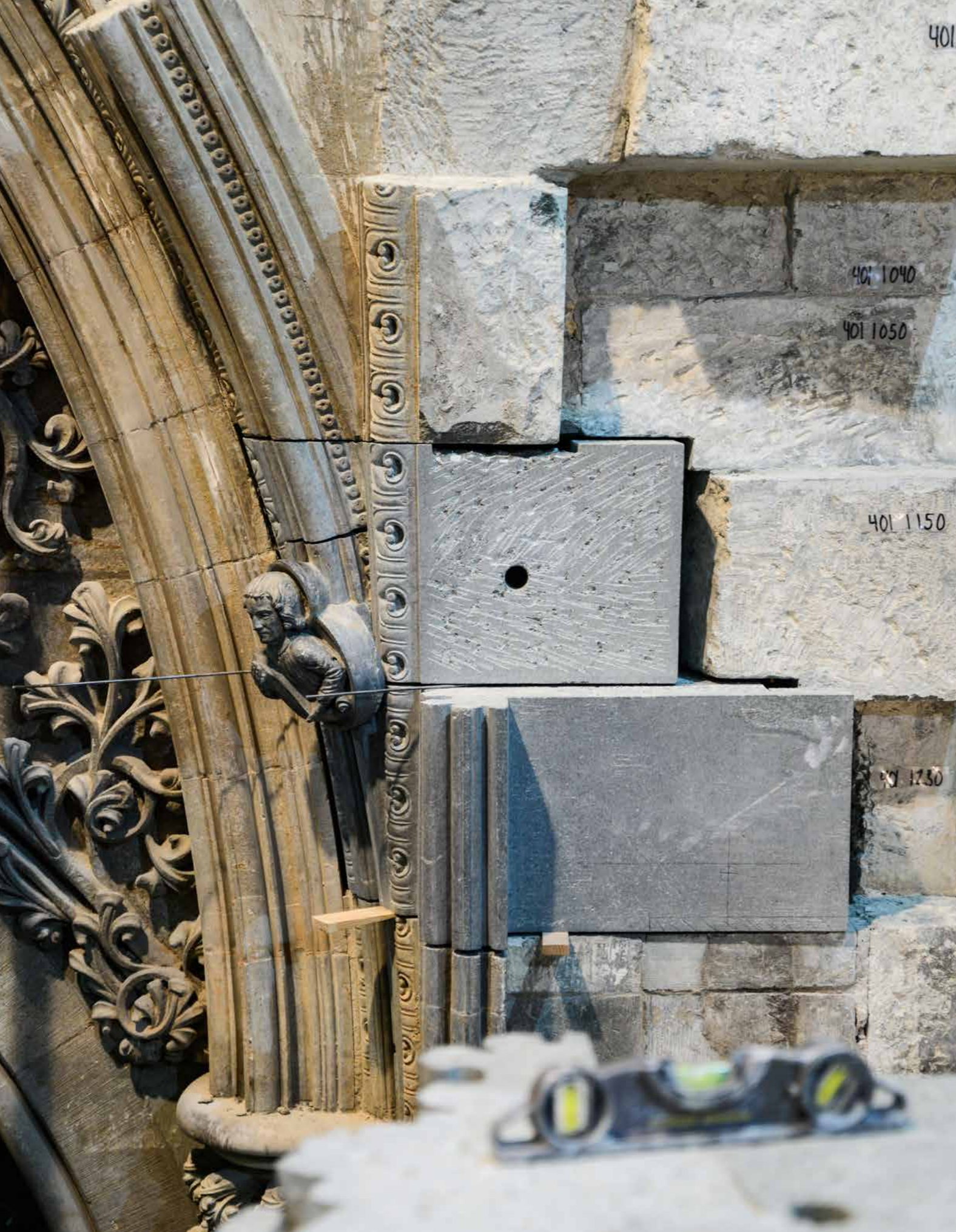
12 Kongeinngangen, med all sin detaljrikdom, krever stor nøyaktighet og kompetanse under restaureringsarbeidet.
