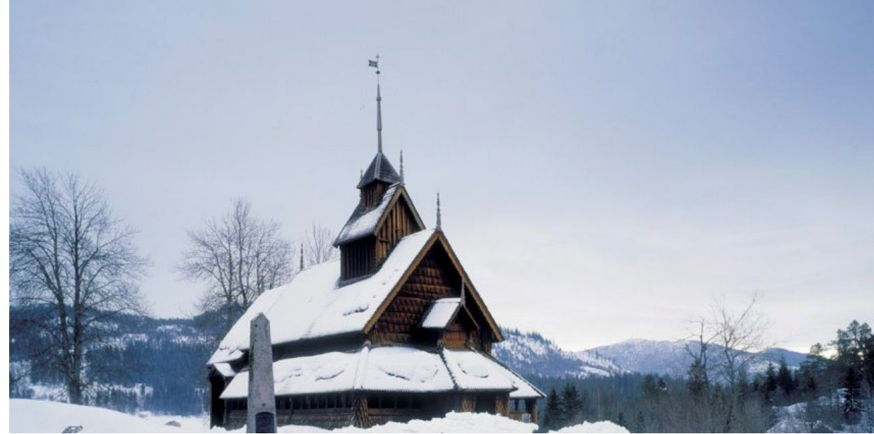
Eidsborg Stavkirke, Tokke. Foto: Jiri Havran, Riksantikvaren
