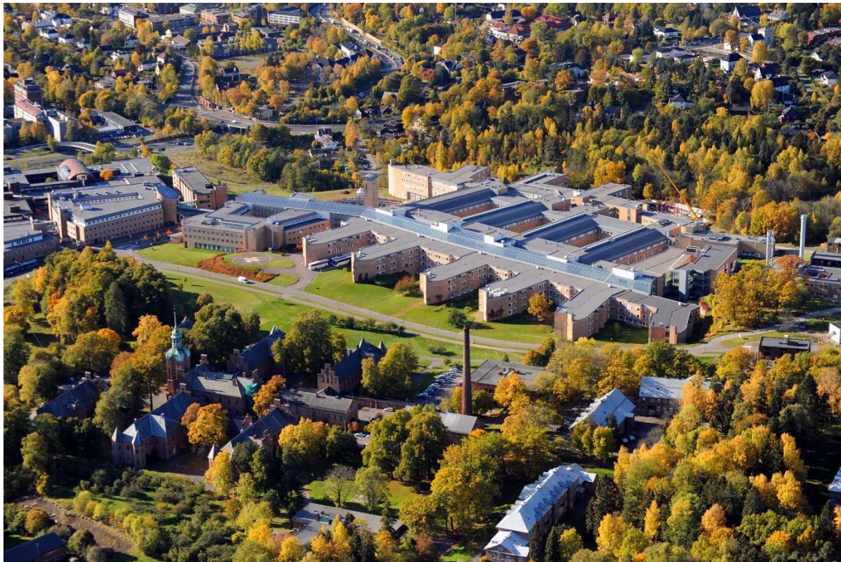
Figur 6 Bilde av eksisterende Rikshospital
