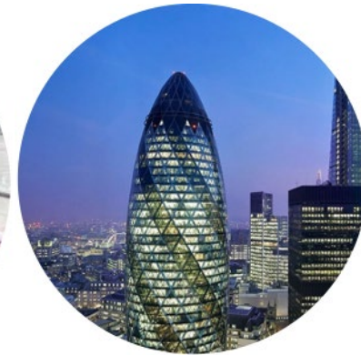
Figur 33. Avrundede hjørner på fasade.
