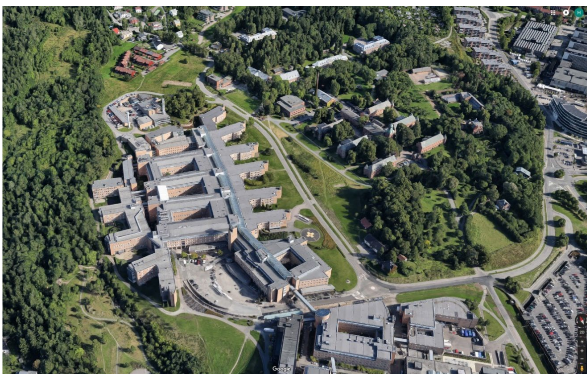
Figur 18 Rikshospitalet sett fra syd. Den glassoverbyggede «hovedgaten» går gjennom anlegget fra ankomsten i syd, med «tverrgatene» ut til sidene. Adkomsttorget med trikkens endespor sees i bildets underkant. Syd for trikkesporet ligger pasienthotell, sykehusets forskningsdel og Domus Odontologica. Gaustad t.h. i bildet, syd for dette er miljøet med Bergvillaen og Forvalterboligen. Foto fra Google maps
