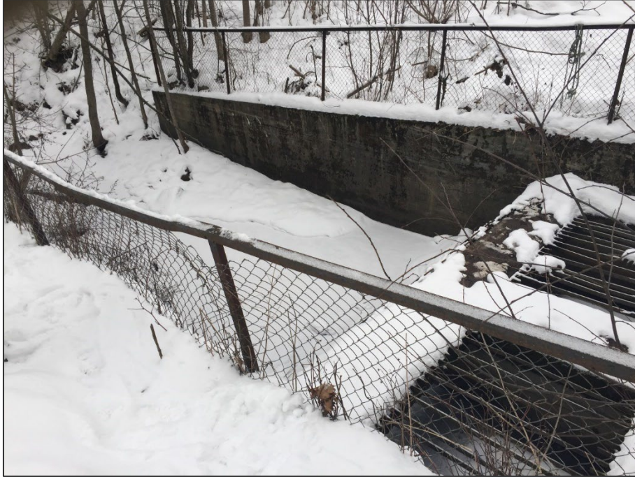
Figur 8. Innløp til kulverter under Ring 3 (foto: Rambøll).
