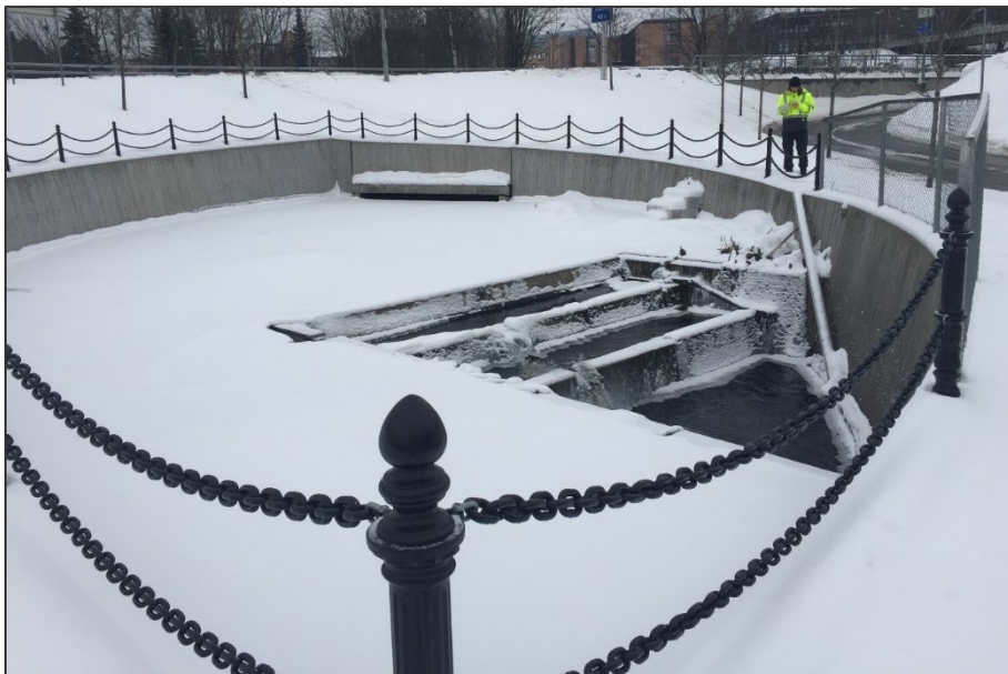
Figur 9. Basseng på sørsiden av Ring 3 (foto: Rambøll).
