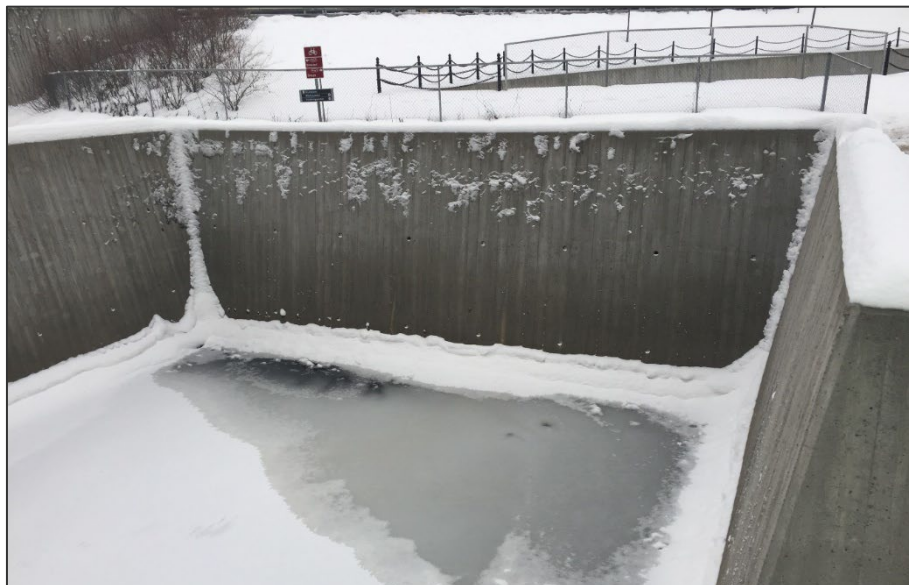
Figur 10. Utløp kulvert fra basseng (foto: Rambøll).
