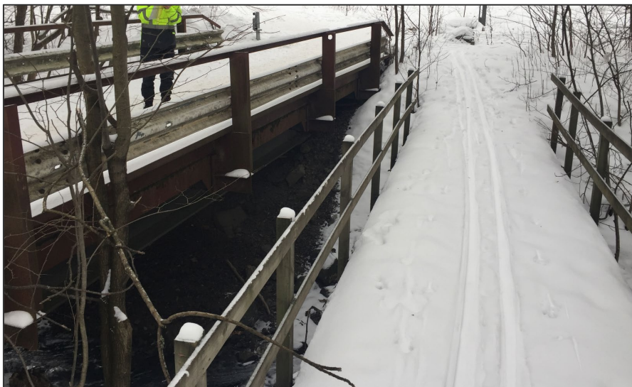
Figur 7. De to gangbroene ved planområdet. Venstre bro (oppstrøms) ligger høyere enn den til høyre (nedstrøms) (foto: Rambøll).
