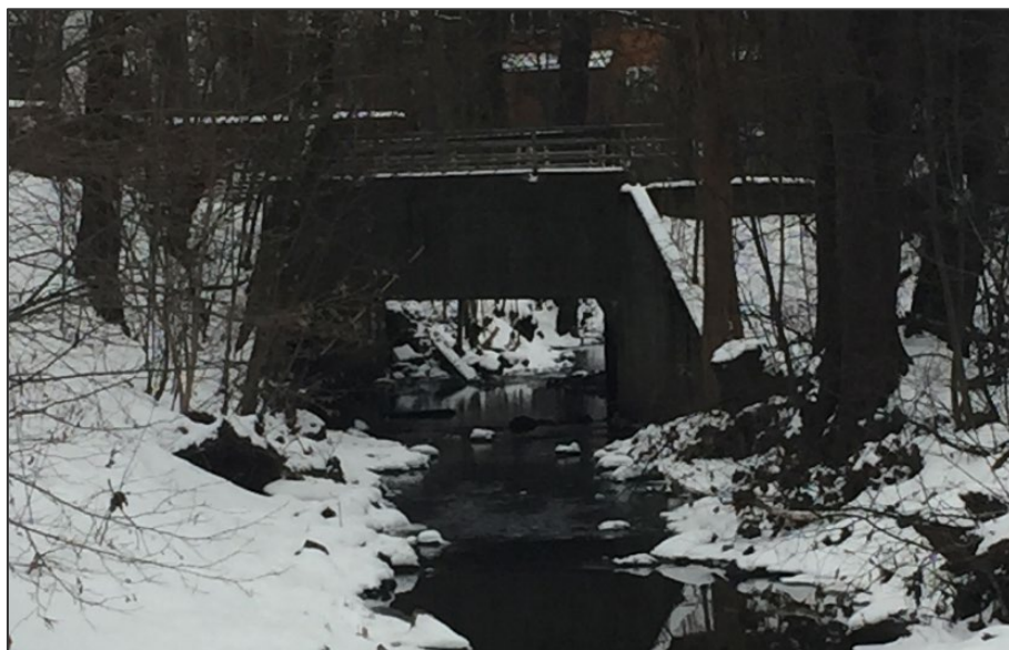
Figur 11. Bro Forskningsveien. Sett medstrøms (foto: Rambøll).
