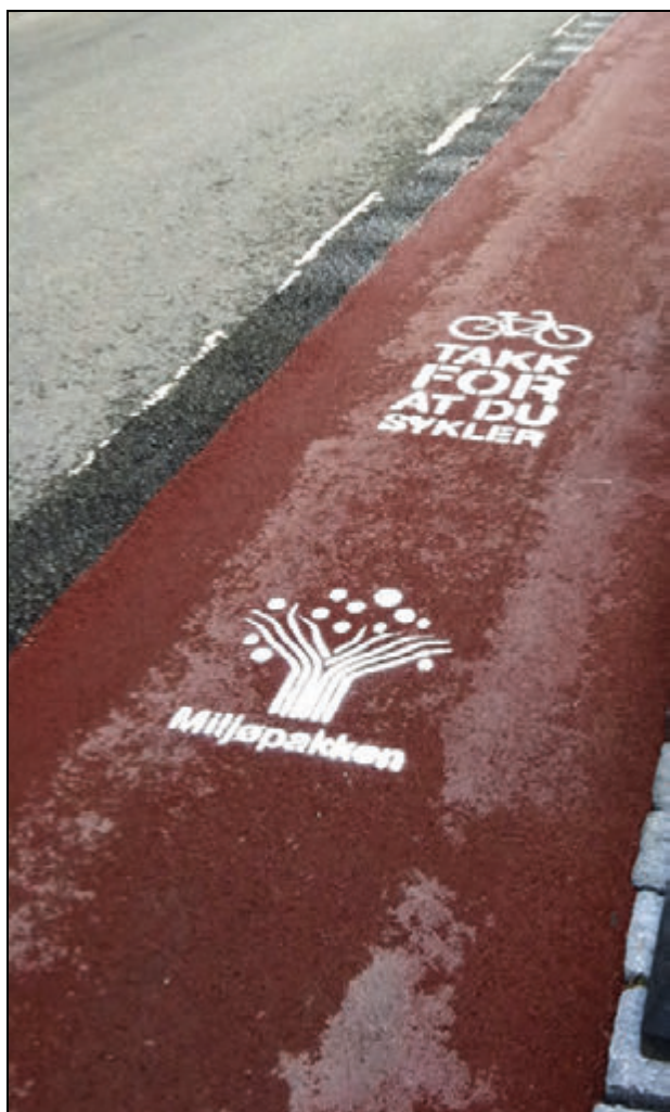
Figur 13.2 Sykkelfelt med farget asfalt gjennom Midtbyen i Trondheim. Den røde fargen markerer sykkelfeltet og gir et godt skille mellom sykkelveg og fortau samt vegbane. Det er hvit markering utenfor det røde feltet for å gi en ekstra tydelig avgrensing mot vegbanen.
