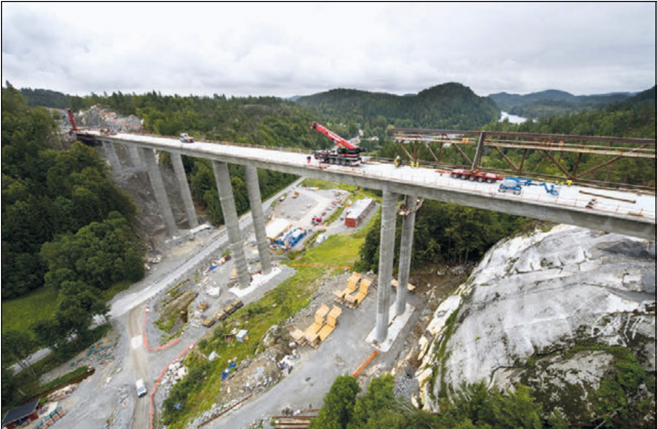
Figur 7.1 Vassbotnbrua på E18, Vestfold.
