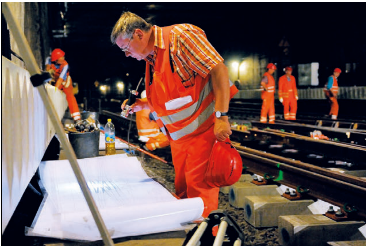
Figur 6.1 Tunnelarbeid på jernbanen.
