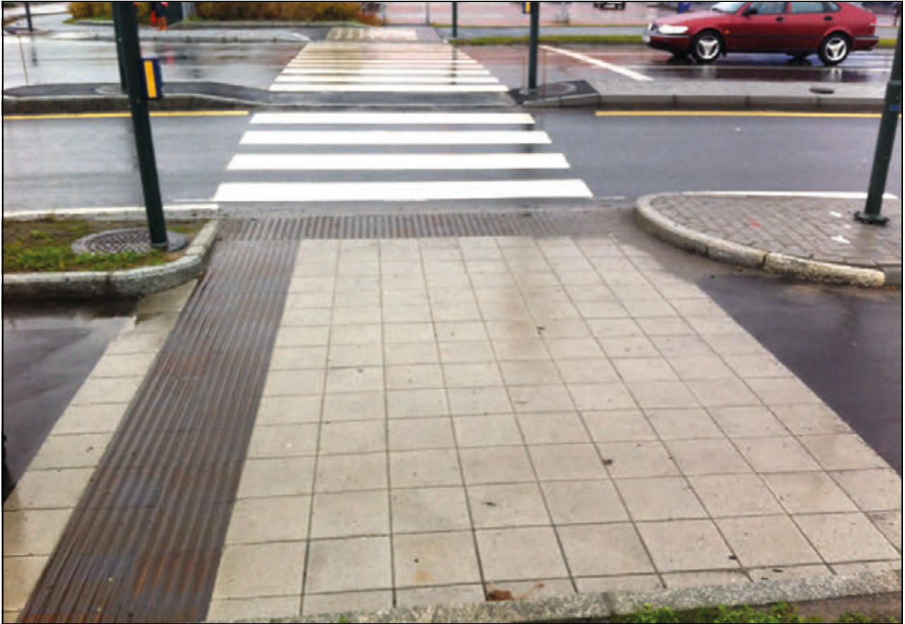
Figur 13.1 Universelt utformet kryss ved Nenset, Skien.
