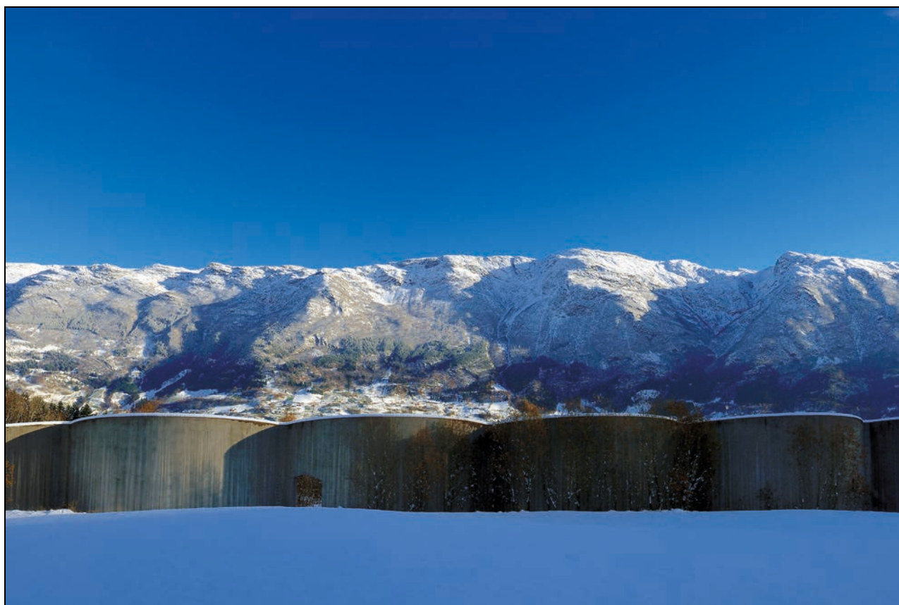
Figur 2.2 Skredmur i betong – Hardanger
