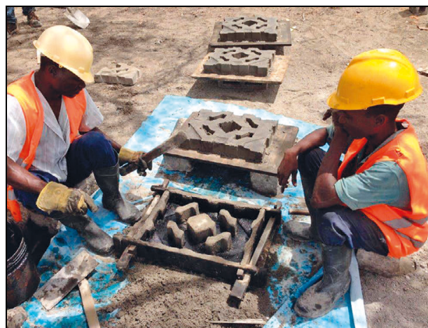
Figur 4.7 Mosambik, Palma. To ufaglærte arbeidere produserer murstein for hånd. De er ansatt av et lokalt selskap som utvikler en industripark for olje- og gassnæringen i området.
