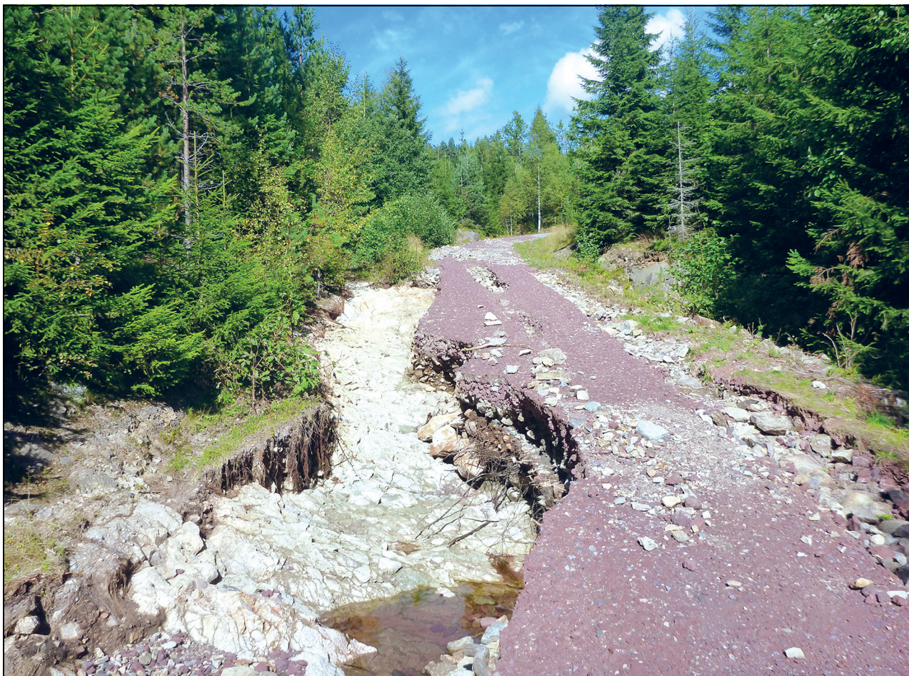
Figur 3.5 Erosjon på skogsveg.
