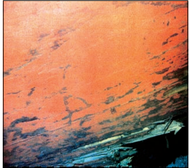
Figur 6.31 Skade i overgang baug/kjøll på styrbord side.
