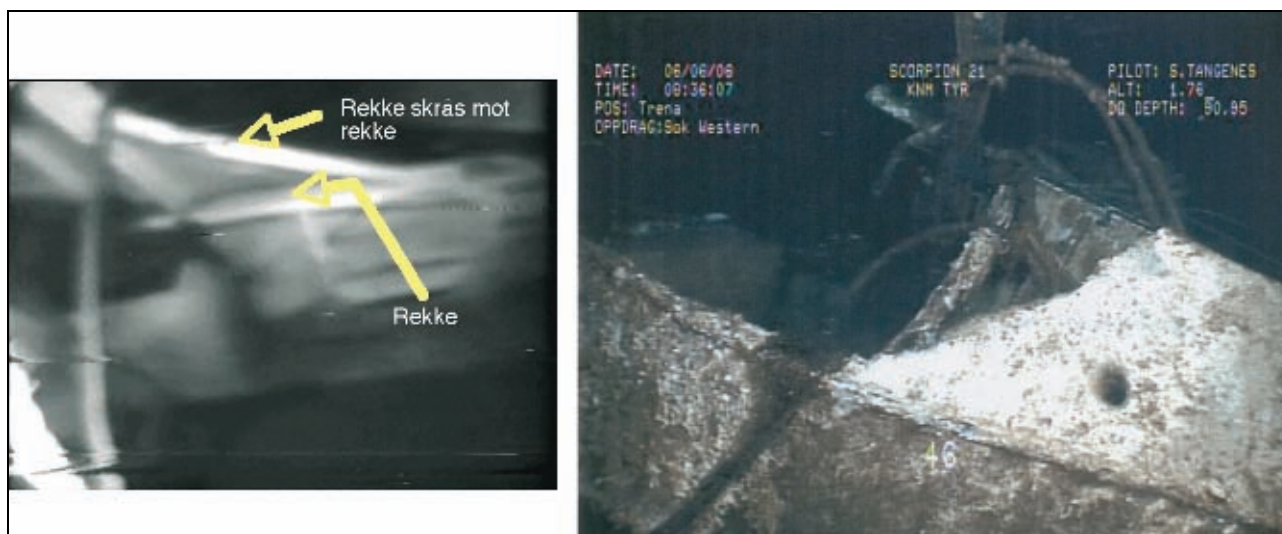
Figur 6.38 Styrbord rekke. Venstre: Sett fra innsiden i april 1981. Høyre: Sett fra utsiden i juni 2006.
