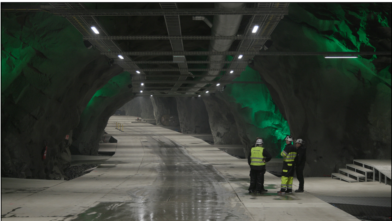
Figur 4.4 Lefdal Mine Datacenter er bygd i en nedlagt gruve mellom Måløy og Nordfjordeid.
