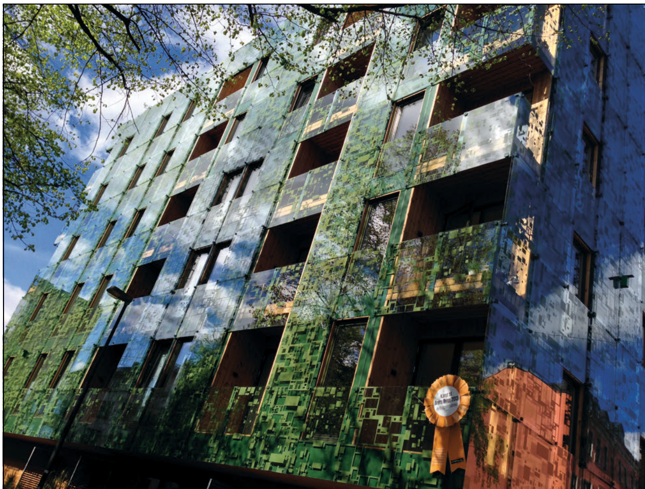
Figur 4.6 Fortetting og nye bustader kan gje positive kvalitetar til nærområda. Dælenenggata 36 i Oslo fekk prisen for årets bygg i 2013. Prisen blir delt ut av Byggeindustrien.
