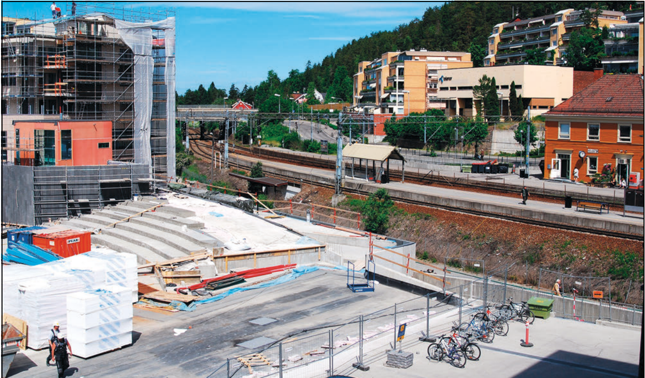
Figur 4.1 Fortetting ved Kolbotn jernbanestasjon.
