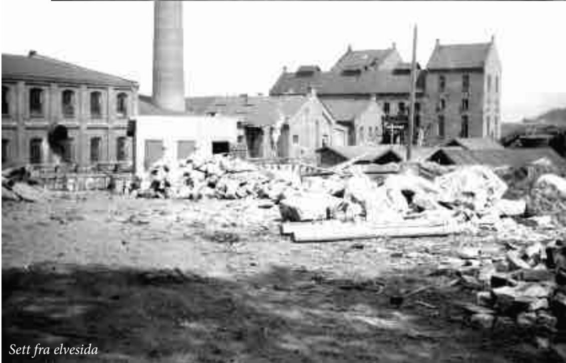
Sett fra Bruksgata
