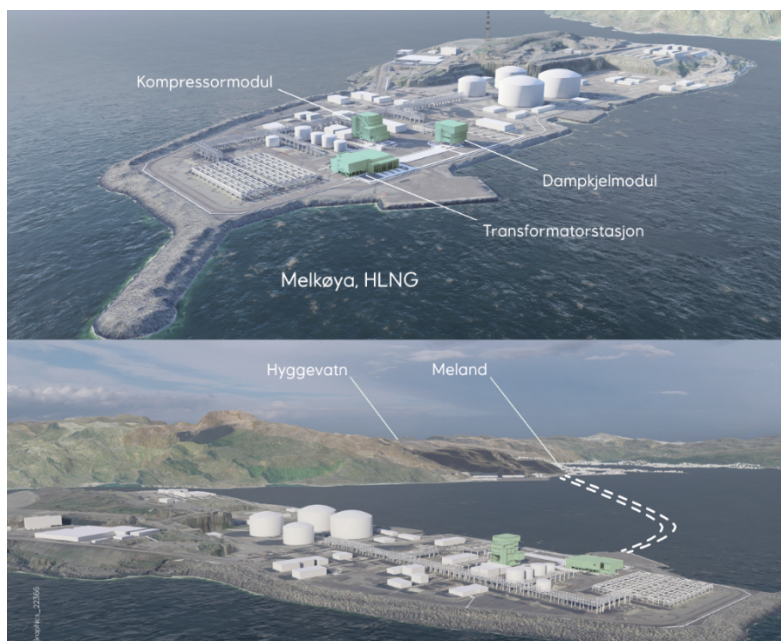
Figur 2: Illustrasjon av Hammerfest LNG (Melkøya) med byggeblokkene i Snøhvit Future.
