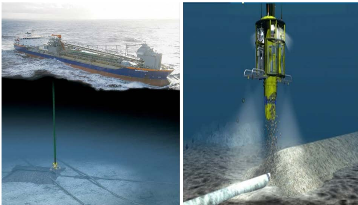
Figur 12 Eksempel på fartøy som utfører tildekking offshore (tv). Endestykke av nedføringsrør for kontrollert utlegging (th). Kilde: Van Oord
