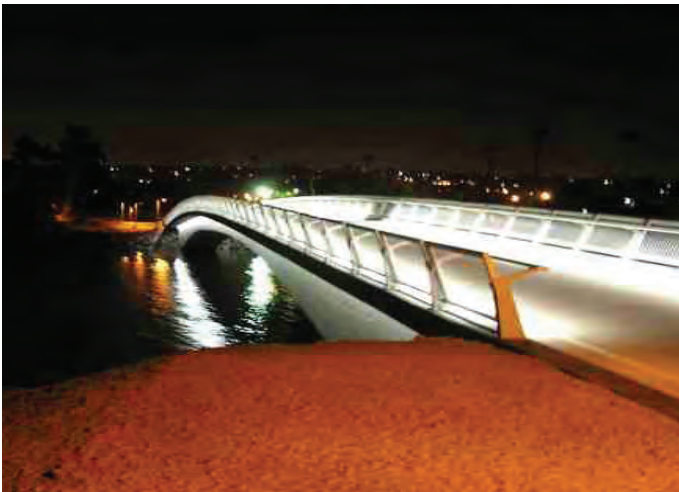
Referansebilde: Belysning integrert i rekkverk på bru
