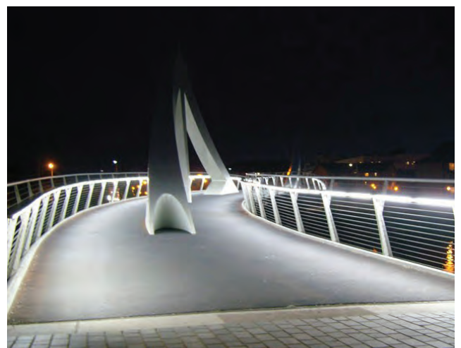
Referansebilde: Belysning integrert i rekkverk
