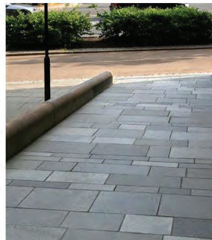
Fortauene i Johan Nygårdsgate og Storgata belegges med Ottaskifer (referansebilde fra Heimdal)
