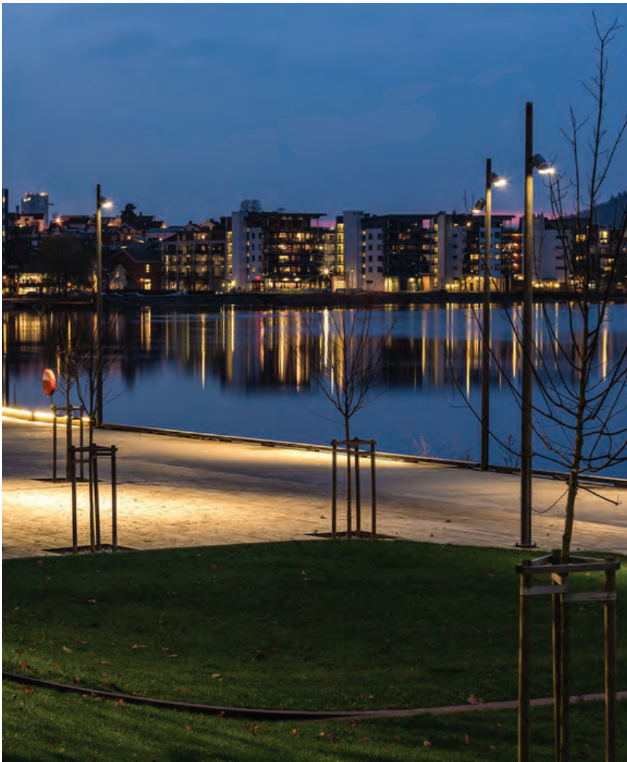
Referansebilde: Lav mast med avskjernet armatur
