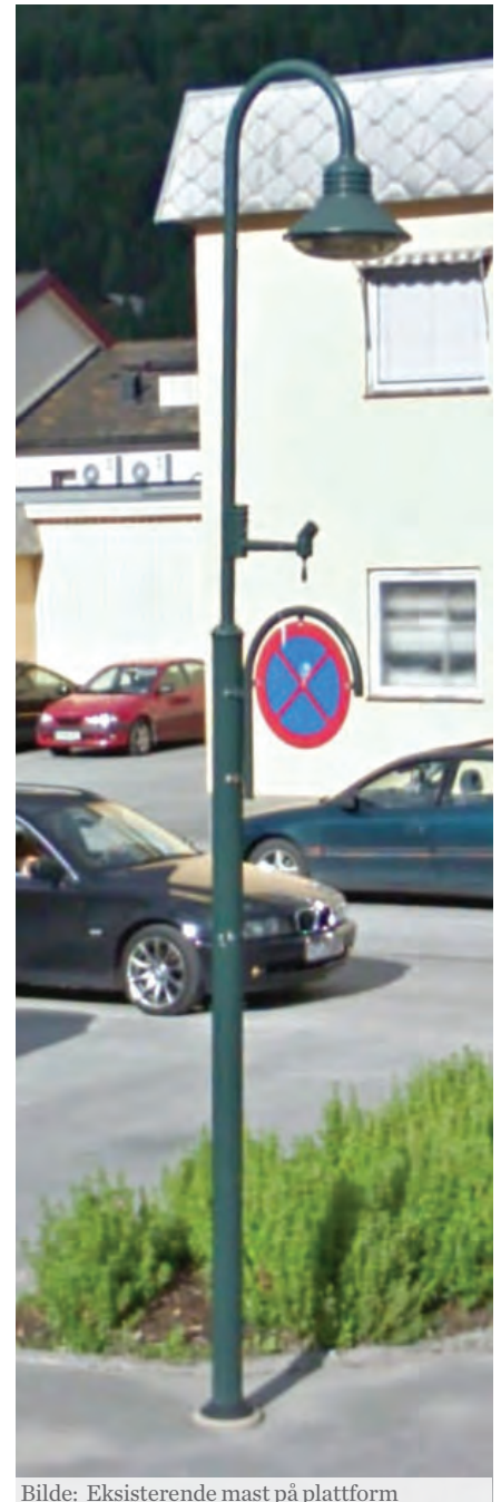
Bilde: Eksisterende mast på plattform
