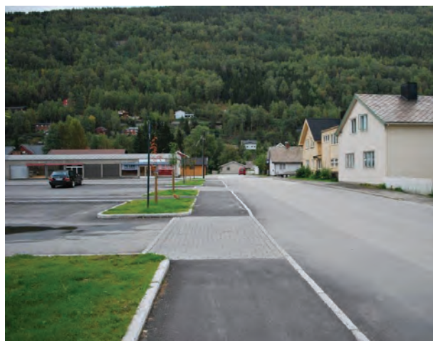
God løsning på Otta: Gangfelt er beholdt forbi avkjørsler, kryssing av kjørefeltet er merket med kontrast i belegget
