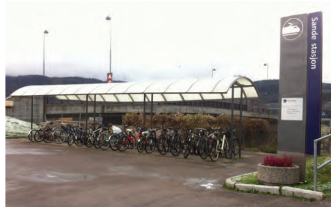
Sykkelparkering under tak. Sande stasjon.
