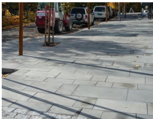
Referansebilde: betongheller på fortau
