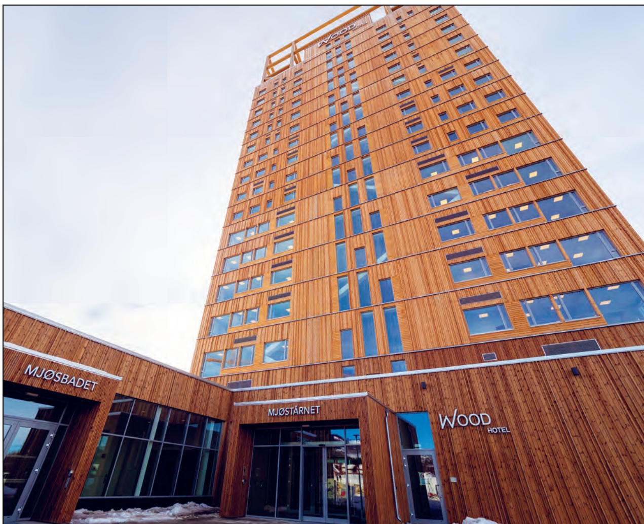
Figur 7.1 Mjøstårnet, det høgaste trehuset i verda, lagrar karbon tilsvarande 3000 tonn CO 2 .
