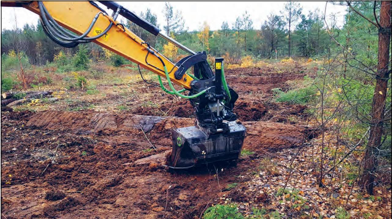
Figur 4.10 Ved restaurering tettar ein gamle grøfter ved å lage vollar med torv og annan masse frå staden. Vegetasjonen på toppen blir løfta av før graving og lagd tilbake etterpå.
