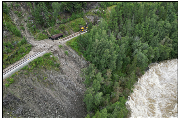
Figur 8.1 Overvåkning av et ras på jernbanen ved bruk av drone
