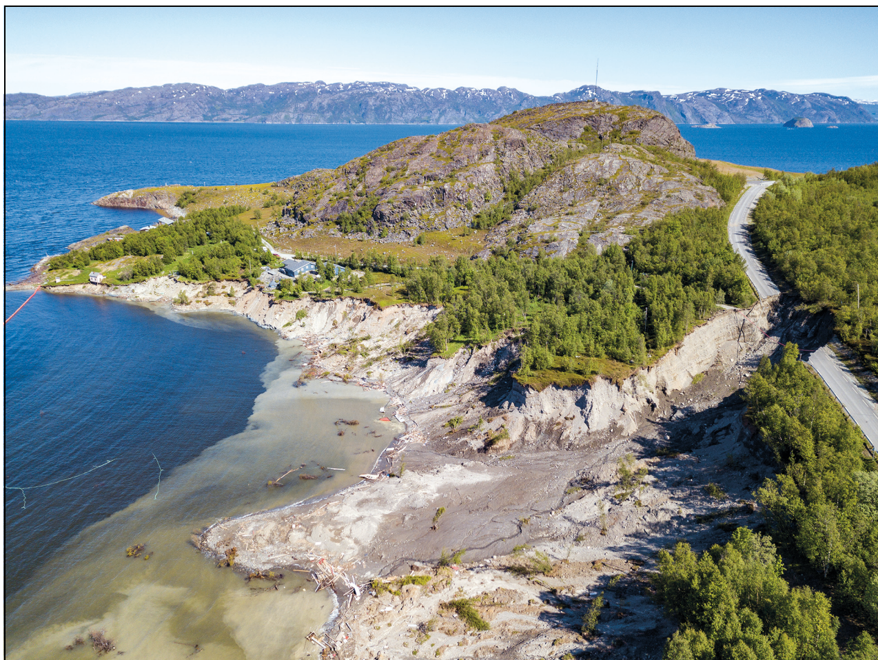
Figur 3.2 Skredet på Kråknes i juni 2020.
