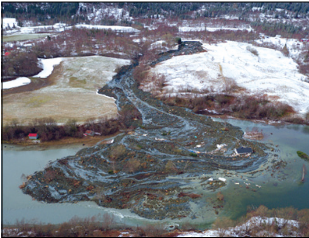
Figur 3.10 Skredet ved Jonsrud i Vefsn 2020.
