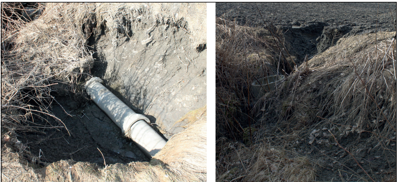
Figur 10.3 Eksempel på frostskafer og erosjon i lukkede kanaler i planerte jordbruksområder.
