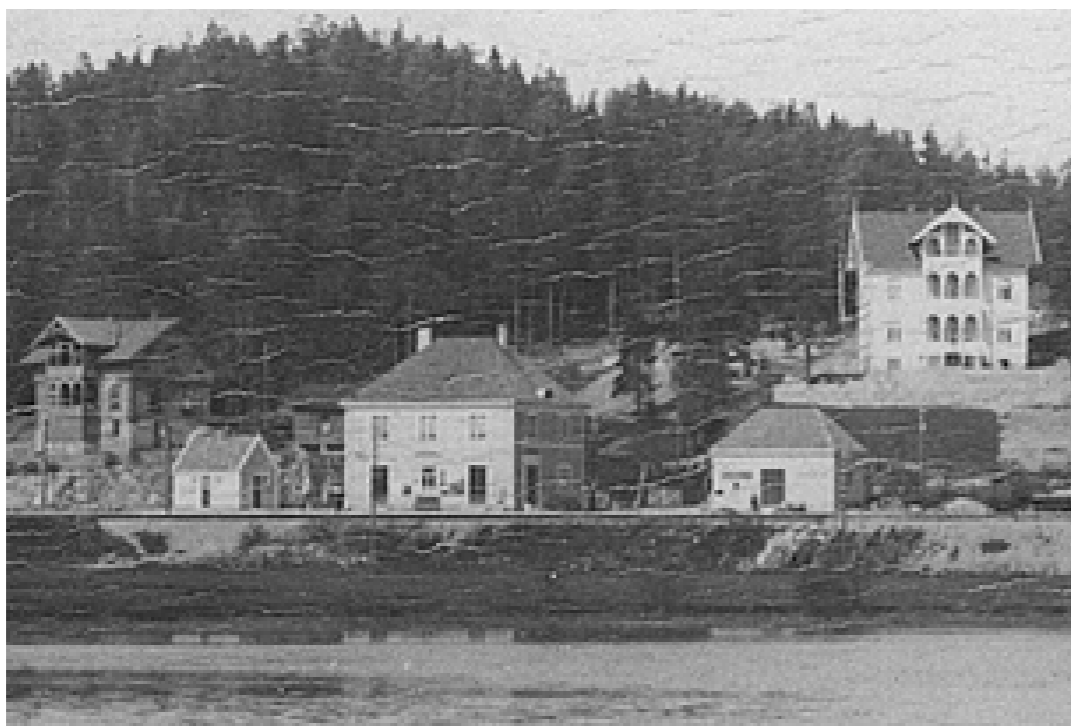
1912: Kolbotn stasjon bygget, til venstre ses den gamle bilettkiosken, til høyre pakkhuset.
