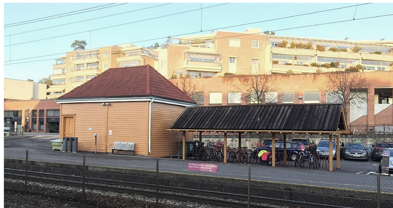
1993: Redusert lengde, nordre del kuttet med ca. 12 m, trolig ble vinduene i nordveggen byttet. Takvalmen ble bevart, men taket ble lagt på nytt ca. 2010
