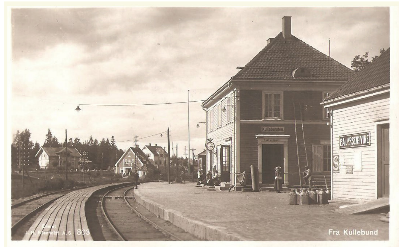
Bildet er fra før 1922, da byttet stasjonen navn fra Kullebunden til dagens Kolbotn
