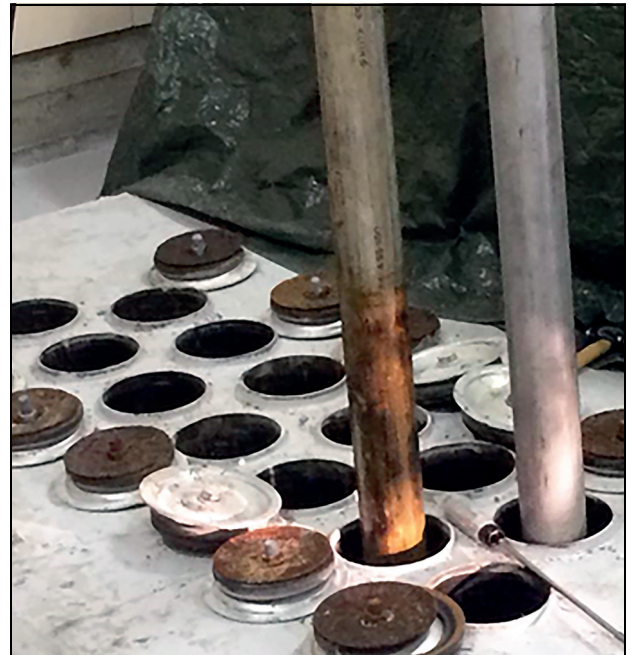
Figur 12.1 Lagring av brukt brensel i JEEP I stavbrønn
