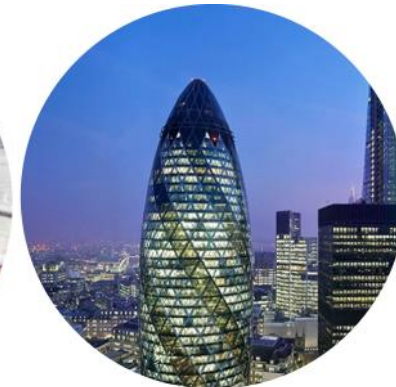
Figur 33. Avrundede hjørner på fasade.
