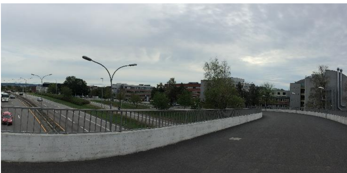
Figur 4: Broen i retning sør-øst.
