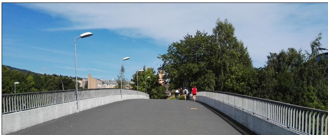
Figur 3: Broen i retning nord.
