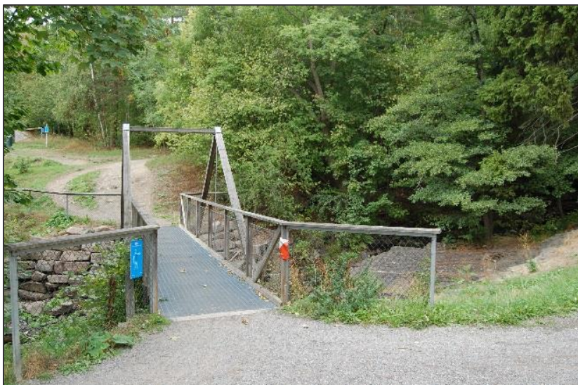
Figur 25. Over Sogsvannsbekken (himmelretning: mot vest).
