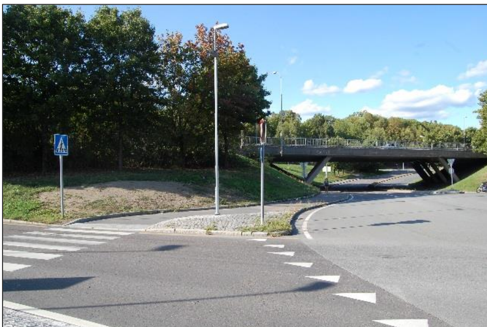
Figur 29. Gjennom trafikkanlegg ved Ring 3 (himmelretning: mot nord-øst).
