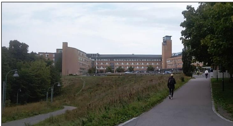
Figur 21. Mot atkomst til sykehuset. Starten på kontinuerlig grøntdrag mot Marka (himmelretning: mot nord).
