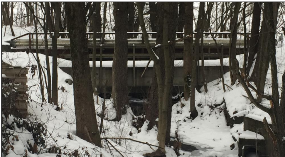
Figur 6. De to gangbroene ved planområdet sett motstrøms (foto: Rambøll).
