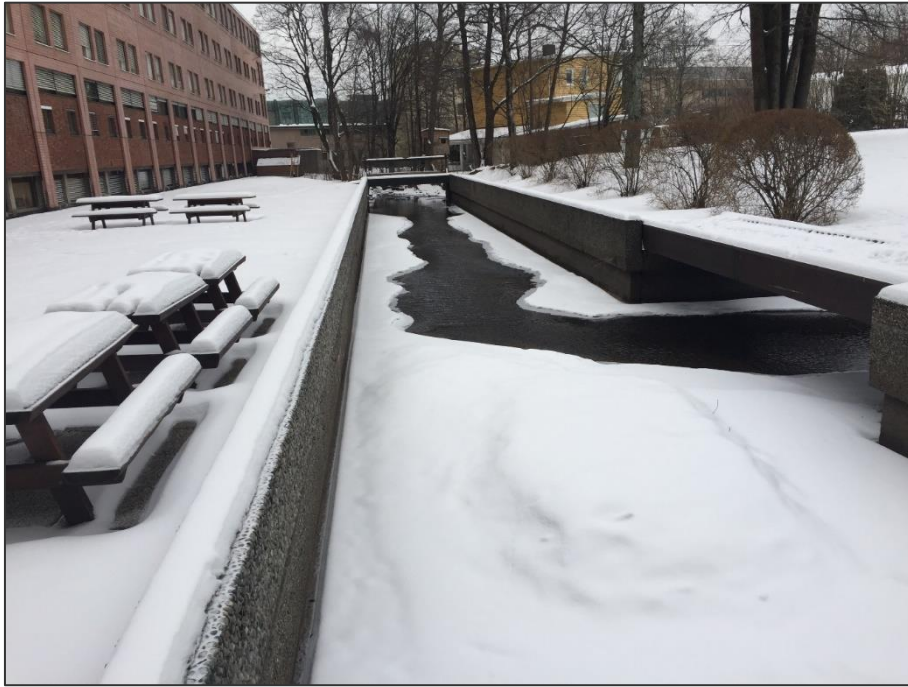
Figur 12. Gangbroer over etablert kanal ved SINTEF-bygg (foto: Rambøll).
