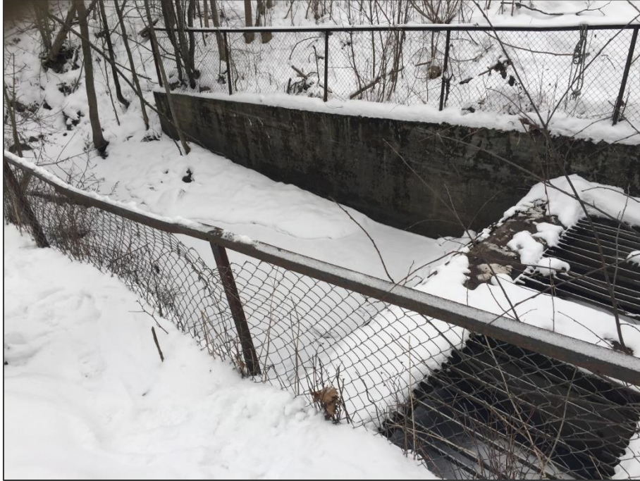
Figur 8. Innløp til kulverter under Ring 3 (foto: Rambøll).
