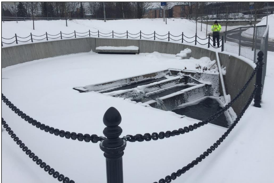
Figur 9. Basseng på sørsiden av Ring 3 (foto: Rambøll).
