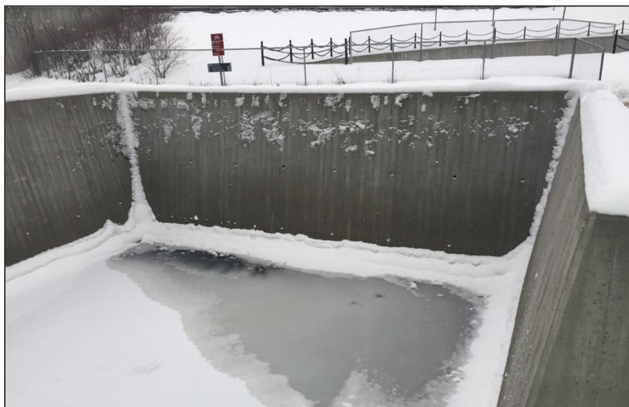
Figur 10. Utløp kulvert fra basseng (foto: Rambøll).
