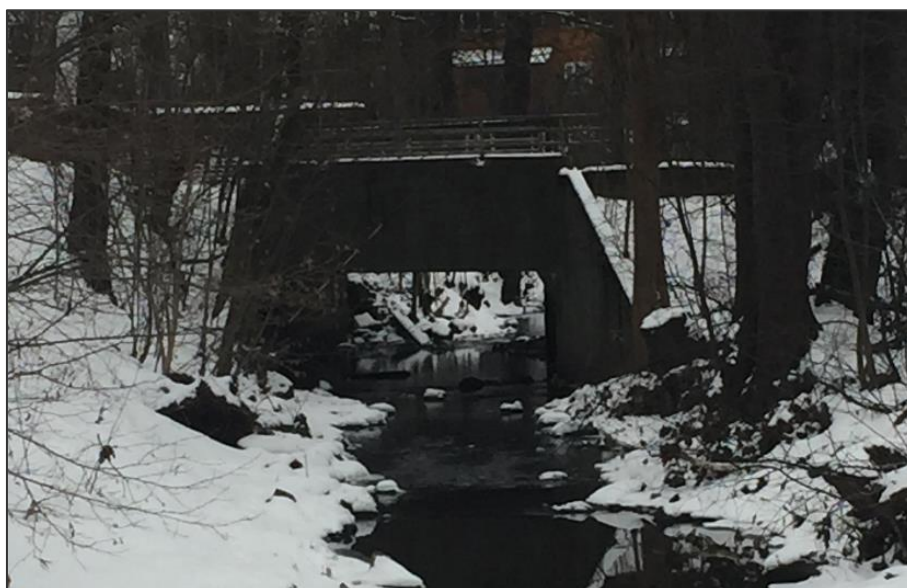
Figur 11. Bro Forskningsveien. Sett medstrøms (foto: Rambøll).
