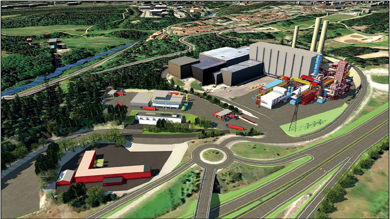
Figur 4.4 Fortum Oslo Varme sitt CO 2 -fangstanlegg
