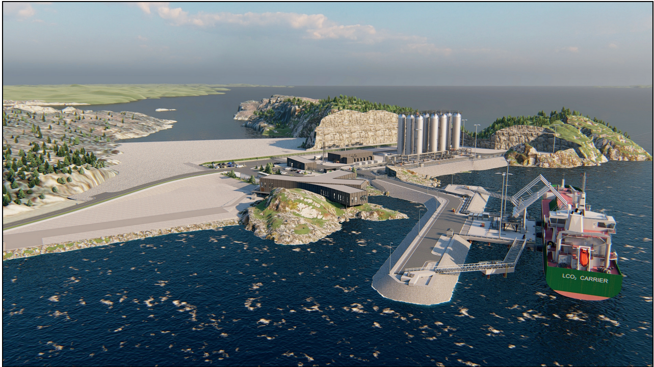
Figur 4.6 Illustrasjon av Northern Lights sin mottaksterminal i Øygarden kommune
