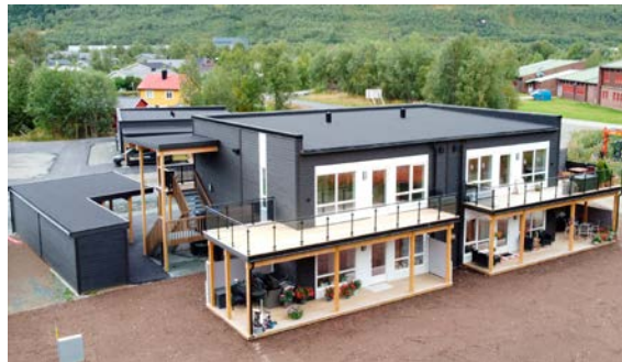
Nybygget og forhåndssolgt firemannsbolig i Balsfjord. Foto: Totalentreprenør Nysted AS
