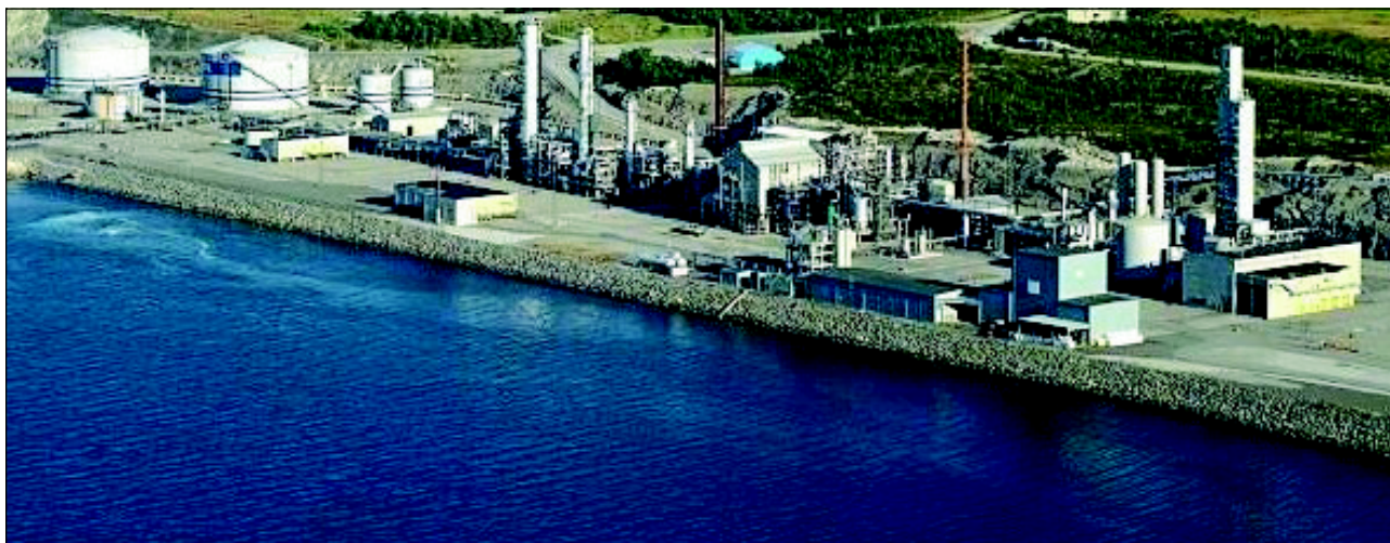
Figur 4.2 Produksjon av hydrogen ved naturgassreformering skjer i dag som mellomprodukt ved Statoils metanolproduksjon på Tjeldbergodden
