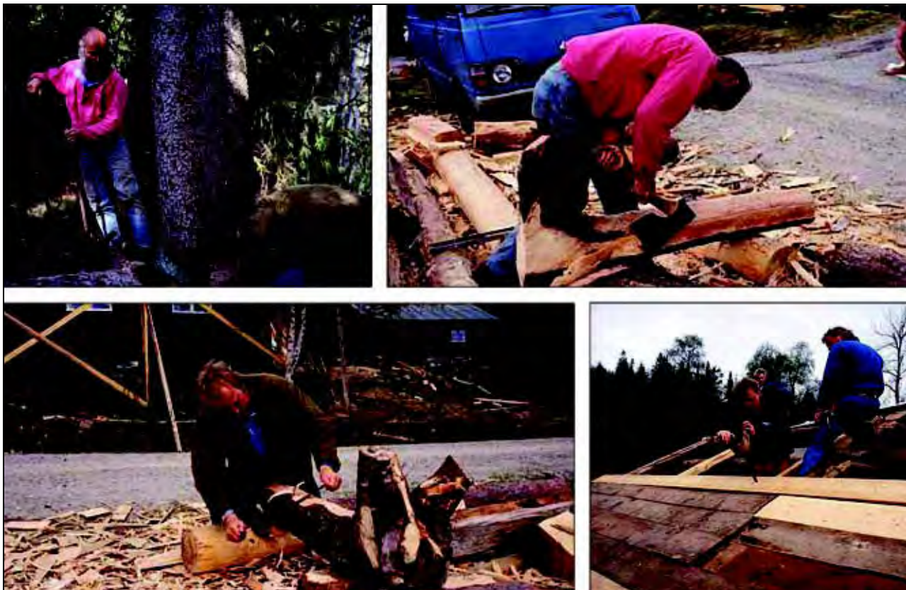
Figur 7.4 Det vil bli etablert et kunnskapsnettverk for kulturhistoriske eiendommer. Nettverket skal sikre eiere og forvaltere av kulturhistoriske eiendommer god tilgang til kunnskap, og det skal bidra til at tradisjonelle håndverk holdes vedlike og videreutvikles.
