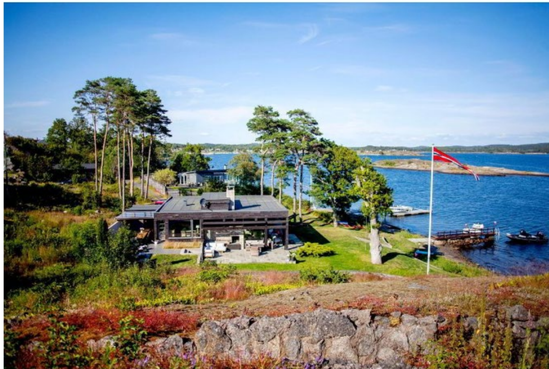
Hytta på Lamøya fikk besøk av Larvik kommune i 2019, som konstaterte en rekke feil, blant annet at bruksarealet var langt større enn hva som var godkjent, samt plattinger, overbygget terrasse og terrengoppfyllinger. (Foto: Javad Parsa)
