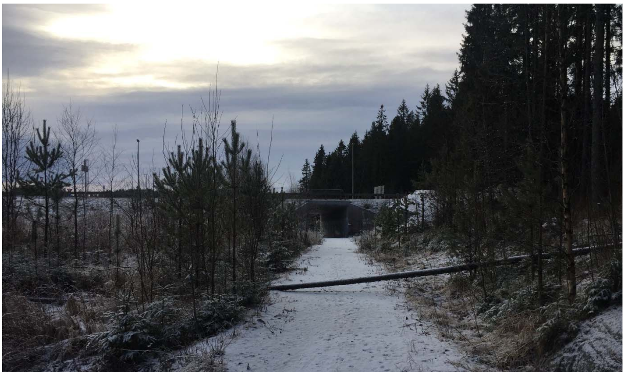
Figur 13. Fotgjengerundergangen sett fra nord
