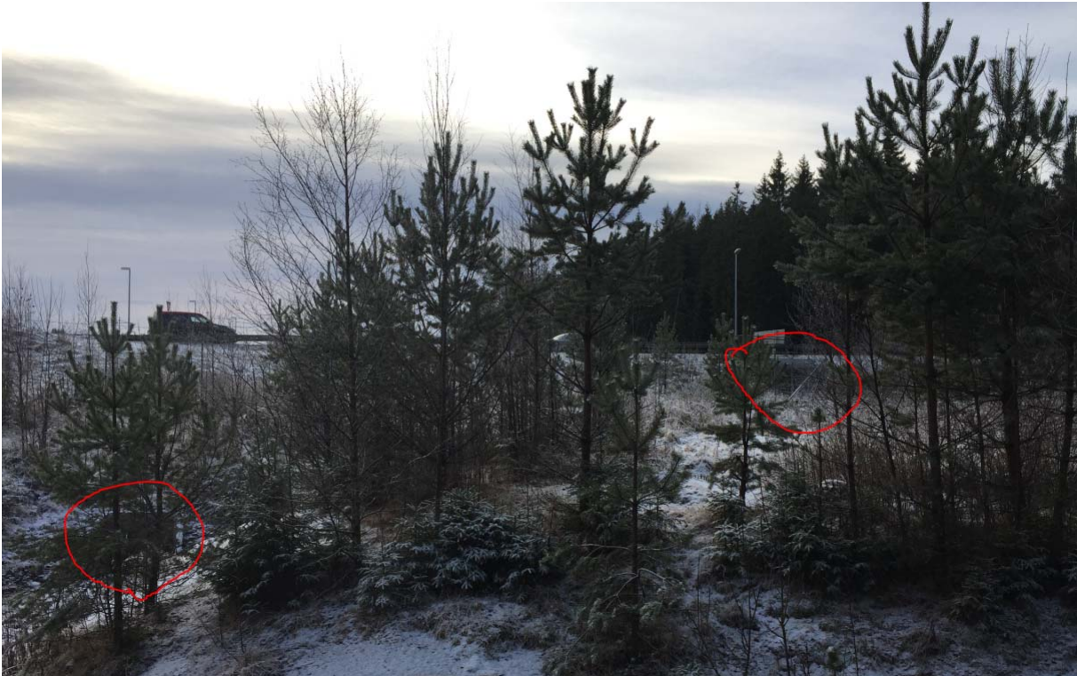
Figur 12. Foto fra nordsiden av rundkjøringa. Stikkrenne til venstre og fotgjengerundergang til høyre. Undergangen vil sørge for at selv ekstreme flommer > 1000 års gjentaksintervall kan passere uten at vannet når veibanen
