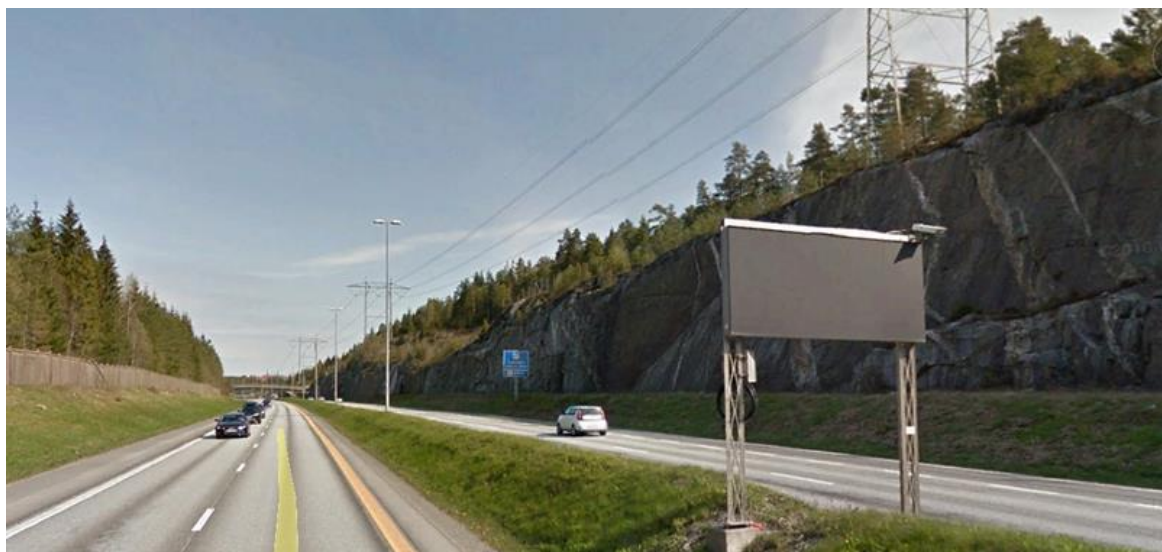
Figur 7-11. Fjellskjæring langs E6, øst for planlagt terminalområde for helikopter.
