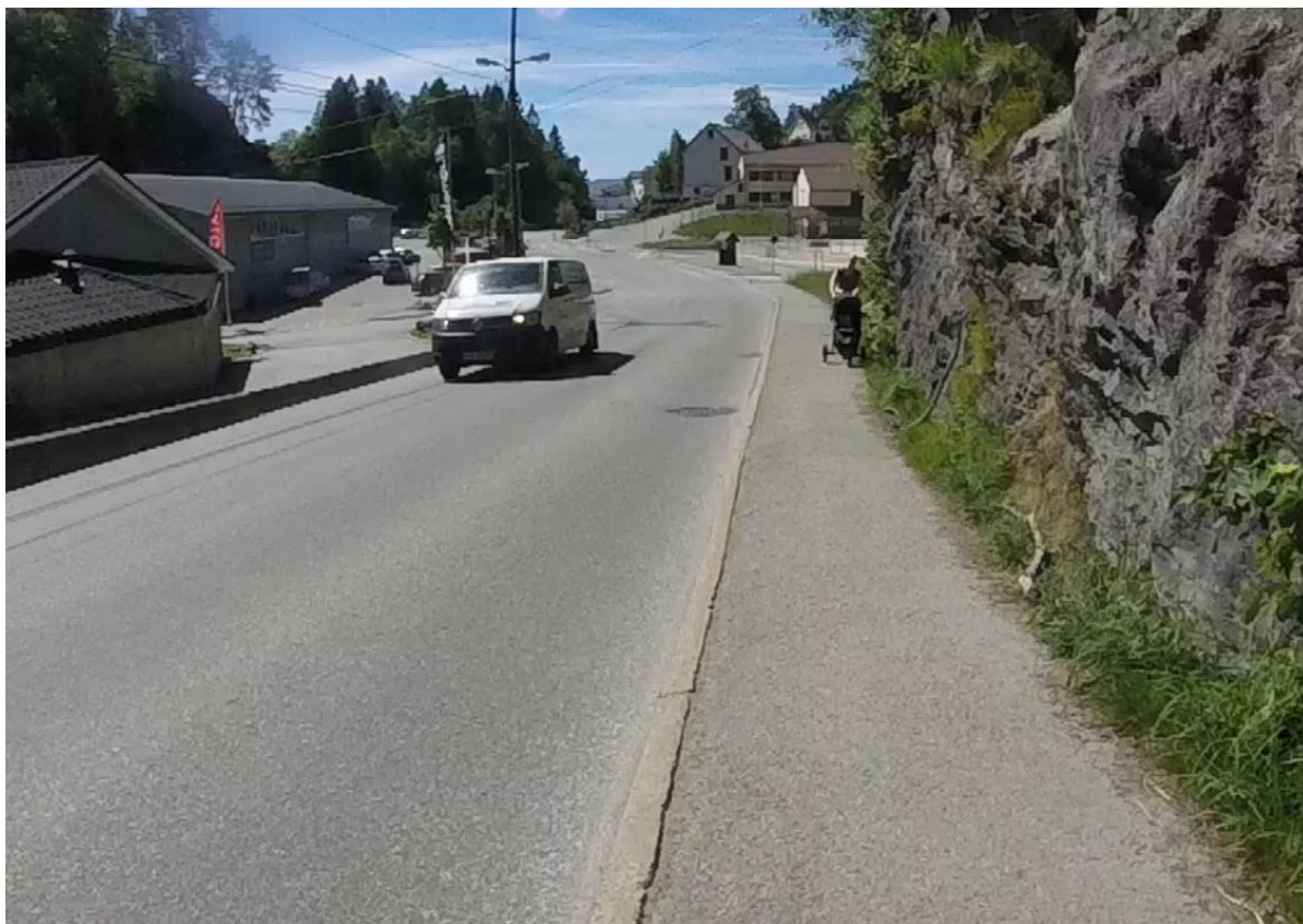
Figur 3-30: Smalt fortau langs Strusshamnvegen. Bilete 33
