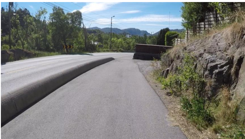
Figur 3-19: Overgang frå breitt til noko smalare fortau før avkøyring til Bakarvågen. Bilete 23
