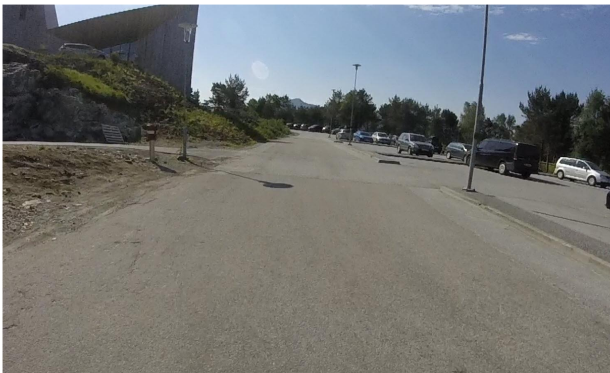
Figur 4-24: Manglende tilbud for syklende langs parkeringsplassen ved Knarvik idrettshall. Bilete 21
