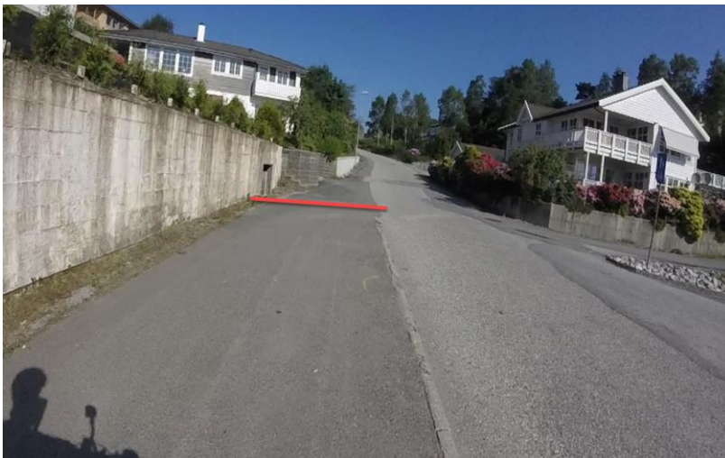
Figur 4-10: Ein av mange overgangar mellom sykling på fortau og sykling i blanda trafikk på delstrekningen. Fortauet endar ved den raude streken. Bilete 10
