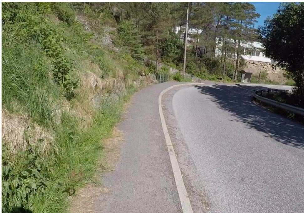
Figur 3-16: Tilbodet til mjuke trafikantar langs Svartedalsvegen. Ca. 100 meter fortau med breidde under 2 meter. Bilete 17
