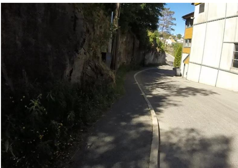
Figur 3-36: Døme på smalt fortau langs Sjødalsvegen der tilbodet er klemt mellom eksisterande bygg og terreng. Bilete 39
