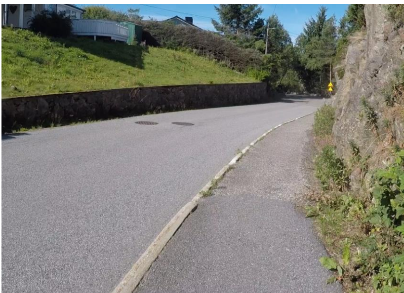
Figur 6-23: Svært smalt fortau langs delar av Lyngsvegen. Bilete 14
