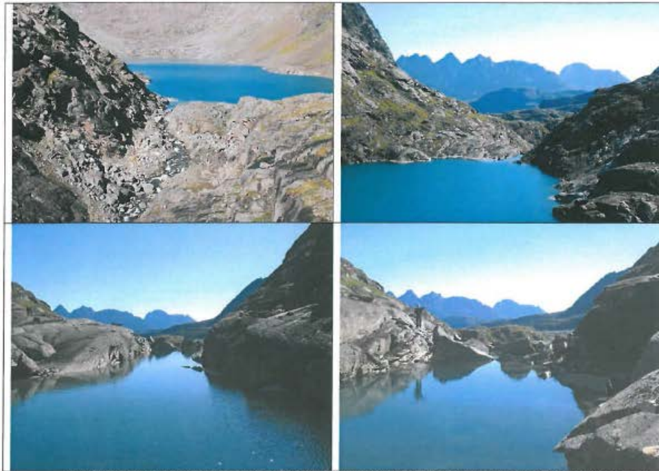
Figur 6 Øverst: Utløpet av Meahccevakejavri sett motstrøms (venstre) og medstrøms. Nederst: Det er fjell i dagen på begge sider av den naturlige utløpskanalen fra Meahccevakejavri. Utgår!
