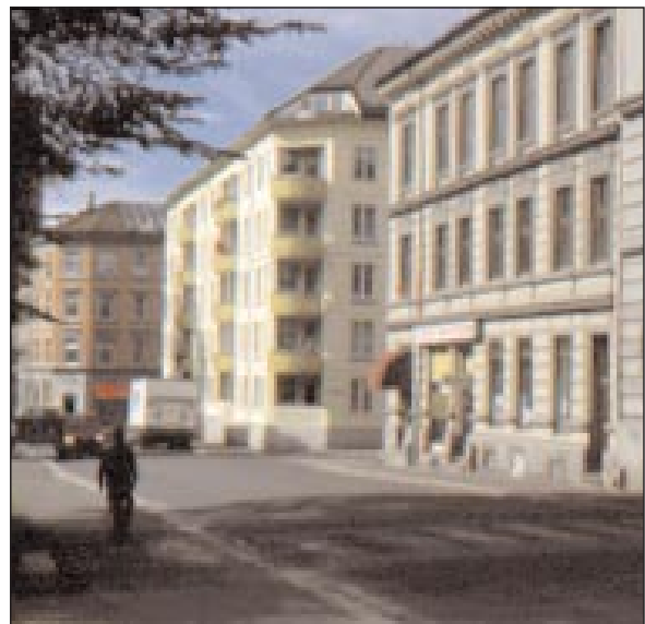
Punktsaneringsprosjektet Åkerbergveien 18 (midt i bildet)
