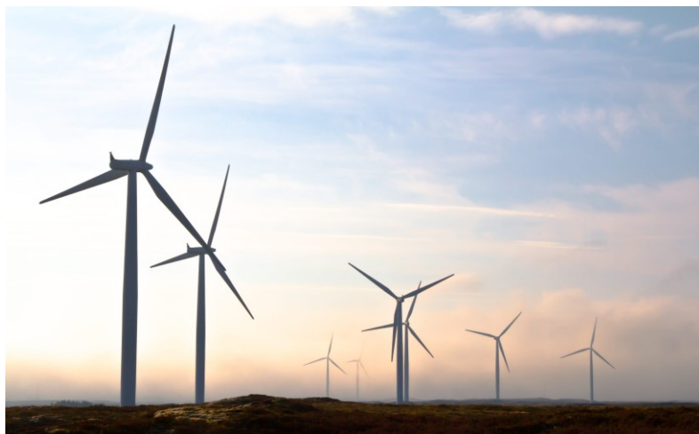
Illustrasjonsbilde av Smøla vindkraftverk
