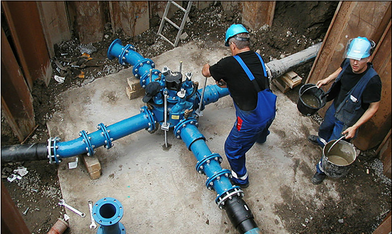
Figur 4.9 Fornyning og vedlikehold av vannledningsnettet er viktig for trygt drikkevann.
