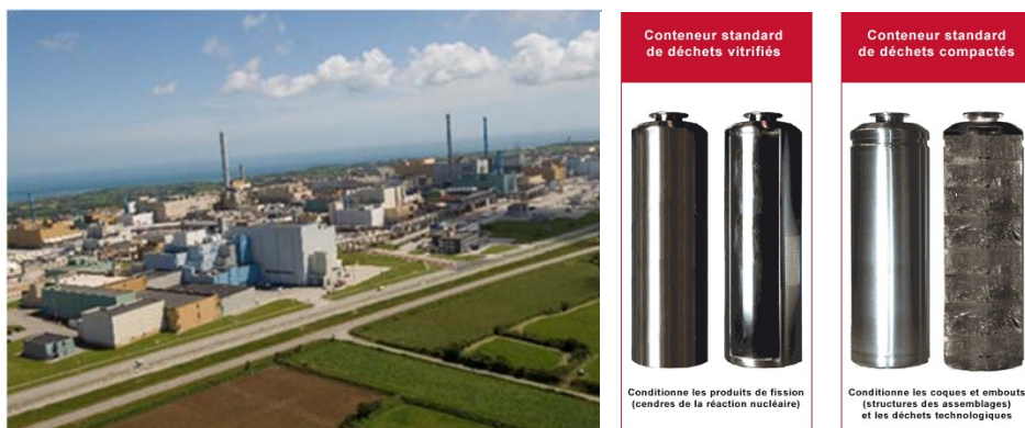
Figur 6-2 Reprosesseringsanlegget i La Hague, Frankrike, og avfallsproduktene som sendes i retur fra represseringen til opprinnelseslandet
