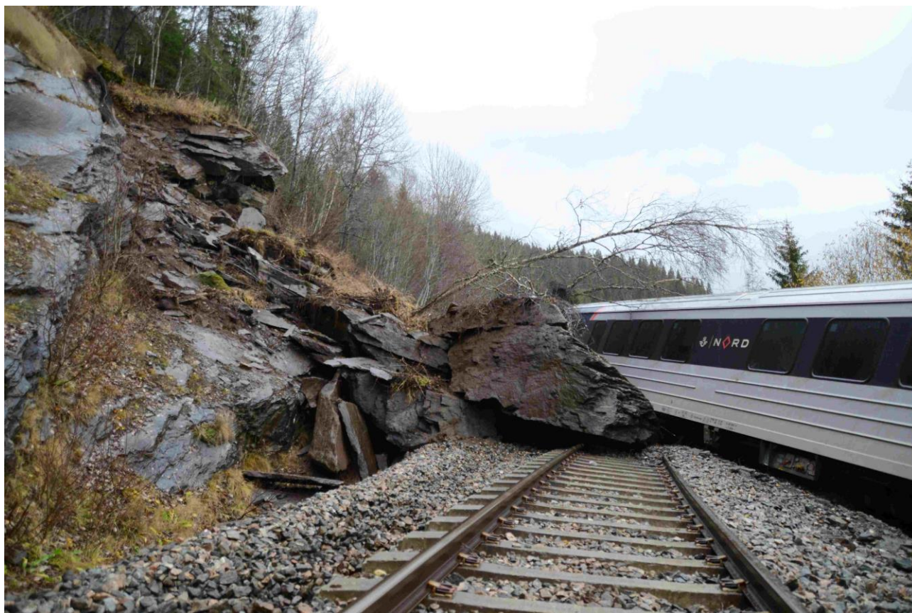
Steinsprang ved Finneidfjord. Foto: SHK
