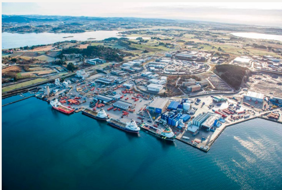
Offshore Terminal Risavika i Tananger. FOTO: ASCO Norge
